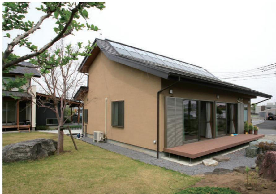
改修後の高崎T邸南側外観。特徴的な二段勾配の屋根は、勾配の緩いところで太陽光発電パネル、勾配の急なところで太陽集熱を受け持っています。
